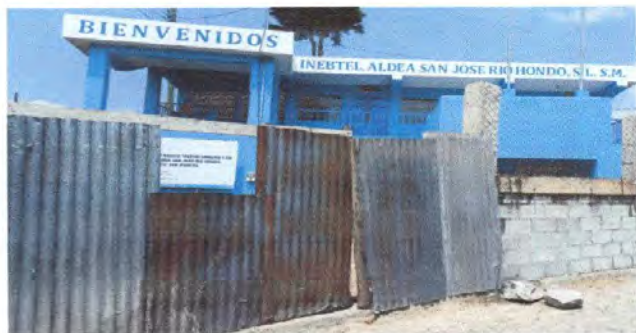
Foto1: Sustrucción de portón de metal en Área de Ingreso
