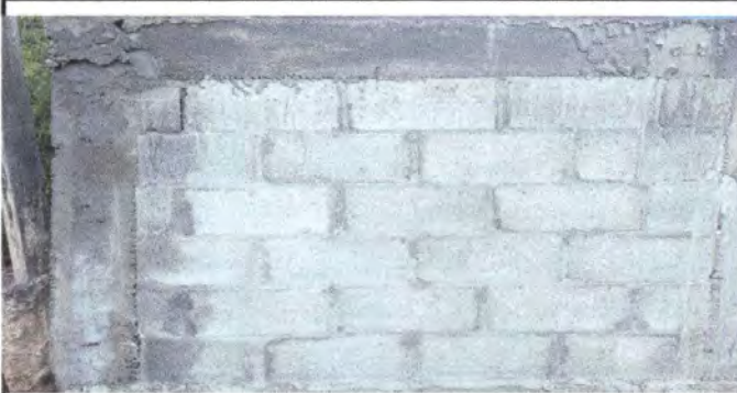
Foto 3: Repello en Muro en Área de Ingreso
