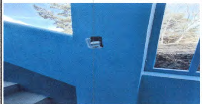
Foto 2: Sustrución de interruptor simple en Módulo 1 de gradas
